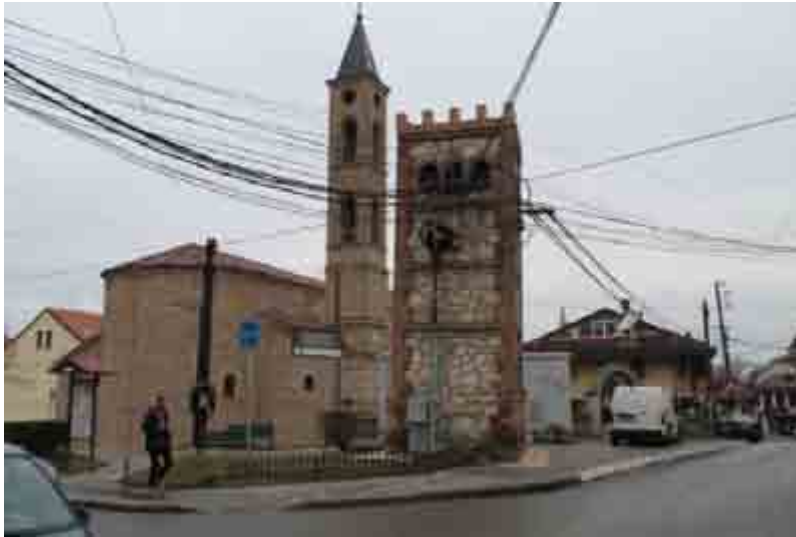
Foto 5. Pamje e kompleksit të Kishës Katolike dhe Trafostacioni i vjetër
